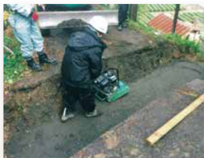
① 基礎材敷設
