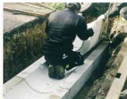
③ 側溝据え付け
