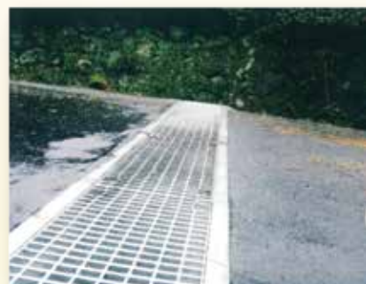
⑥ 舗装完成
