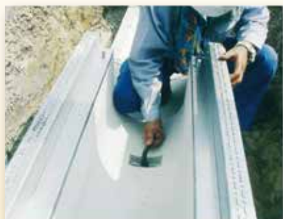
④ 固定ボルト締め
