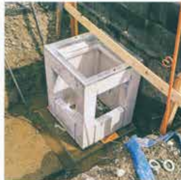
切り溝部分はコンクリート厚が薄く、カットが楽々！
