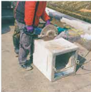
切り溝部分はコンクリート厚が薄く、カットが楽々！
